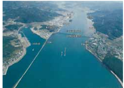
写真 4.3.22 河口付近の状況
