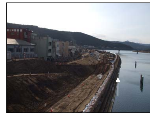
太平橋より下流側を望む
