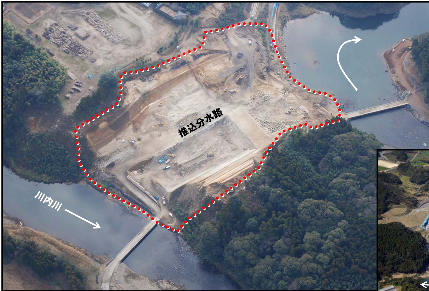
推込分水路を上空より
