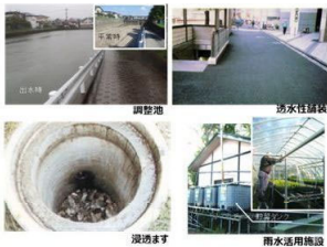
雨水貯留浸透施設の例
