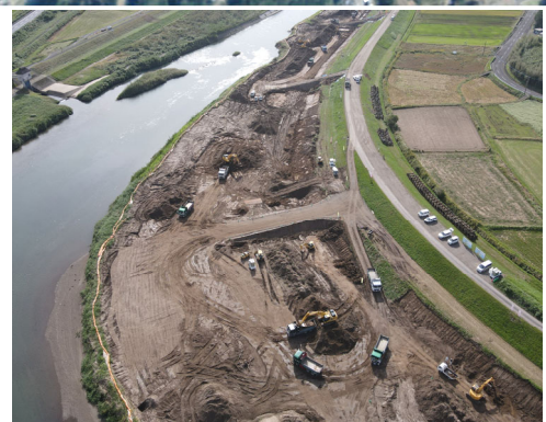
河道掘削の施工状況（栗野地区）
