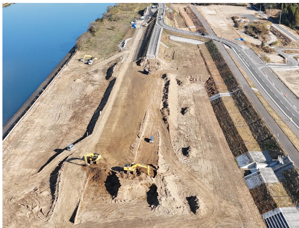
河道掘削の施工状況（天辰第二地区）
