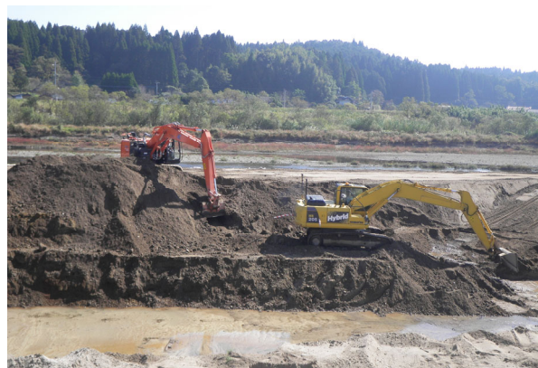
河道掘削の施工状況（羽月川）
