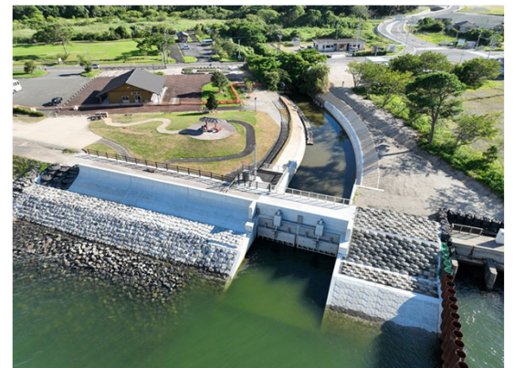
久見崎樋門（R6年度完成）
