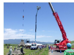
決壊箇所応急復旧訓練
