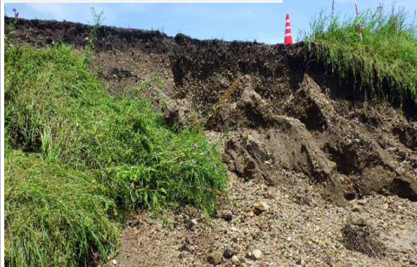
写真①(法面崩落状況)
