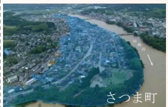
浸水状況（H18.7）
