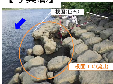
(根固工被災状況: 下流側)
