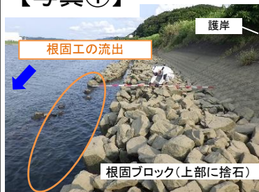
(根固工被災状況: 上流側)
