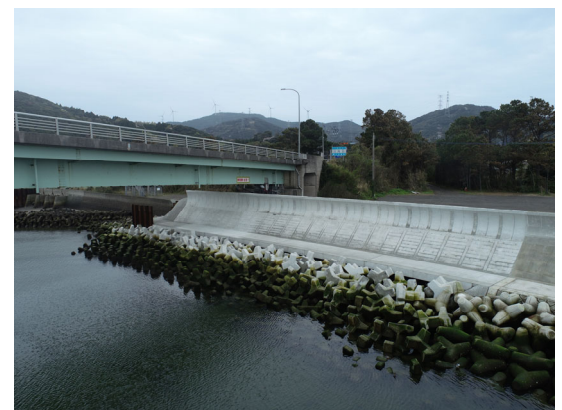
高潮堤防整備 (R7年度整備)
