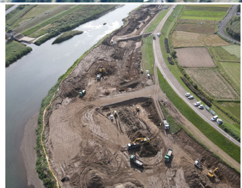
河道掘削の施工状況（栗野地区）
