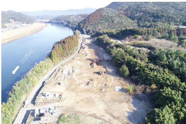
掘削の状況（天辰第二地区）
