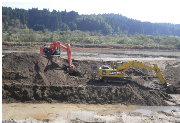
河道掘削の施工状況（羽月川）
