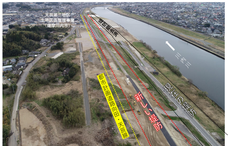
施工状況写真（R8.3時点）
