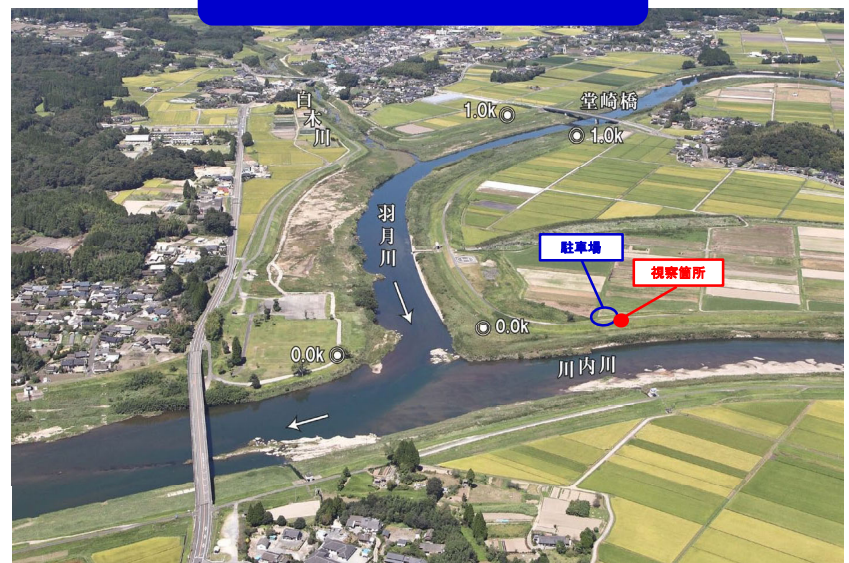
巡視④:川内川右岸67k000付近
