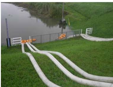
(ポンプ設置状況)
