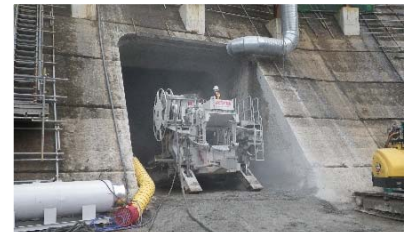
堤体削孔(穴あけ)作業状況
