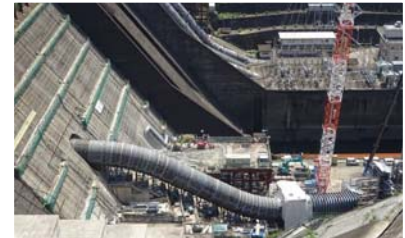
放流管の設置作業状況
