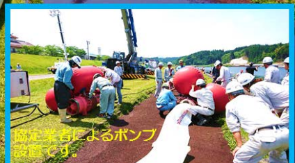
排水ポンプ車は、1分間に30リットル又は60リットル排水するタイプがあり、種類も軽量型、高揚程型などのタイプがあります。
