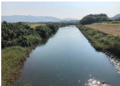
【川内川本川亀沢橋から 上流を望む】
