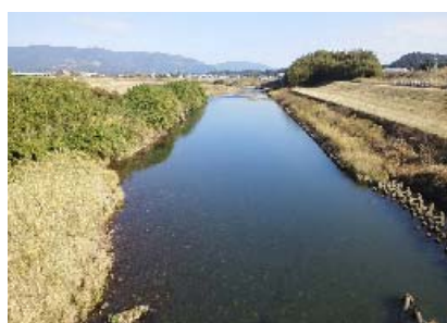
【川内川本川亀沢橋から 上流を望む】
