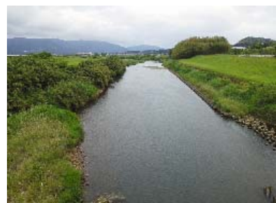
【川内川本川亀沢橋から 上流を望む】
