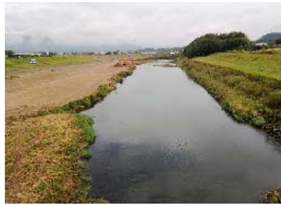
【川内川本川亀沢橋から 上流を望む】
