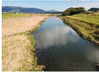
【川内川本川亀沢橋から 上流を望む】
