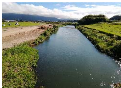
【川内川本川亀沢橋から 上流を望む】
