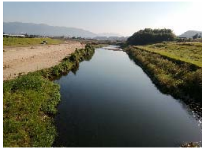
【川内川本川亀沢橋から 上流を望む】
