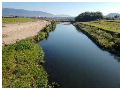
【川内川本川亀沢橋から 上流を望む】
