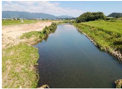
【川内川本川亀沢橋から 上流を望む】
