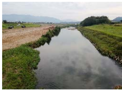
【川内川本川亀沢橋から 上流を望む】
