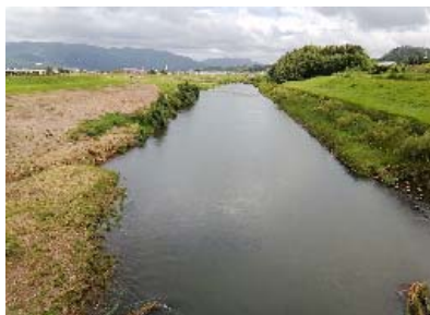
【川内川本川亀沢橋から 上流を望む】
