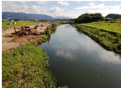
【川内川本川亀沢橋から 上流を望む】
