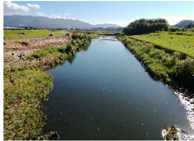
【川内川本川亀沢橋から 上流を望む】
