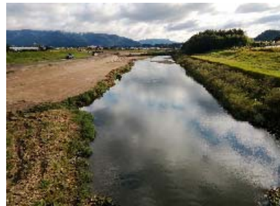
【川内川本川亀沢橋から 上流を望む】
