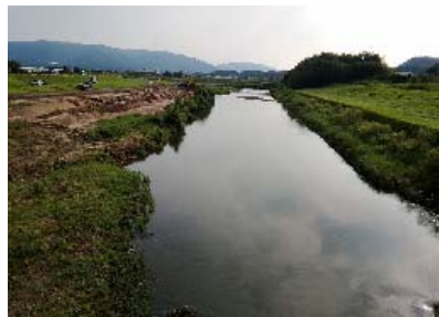
【川内川本川亀沢橋から 上流を望む】
