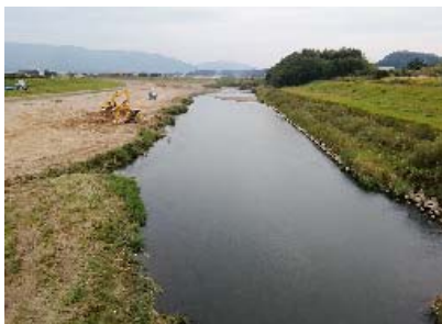
【川内川本川亀沢橋から 上流を望む】
