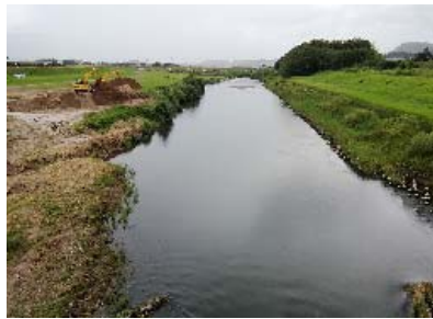
【川内川本川亀沢橋から 上流を望む】
