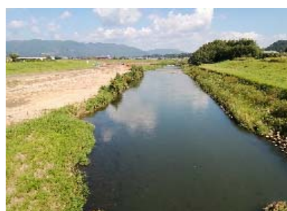
【川内川本川亀沢橋から 上流を望む】
