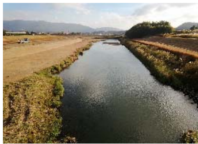
【川内川本川亀沢橋から 上流を望む】
