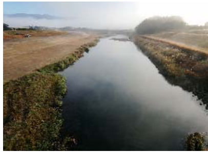
【川内川本川亀沢橋から 上流を望む】
