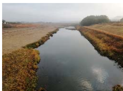
【川内川本川亀沢橋から 上流を望む】
