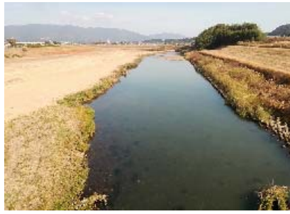
【川内川本川亀沢橋から 上流を望む】
