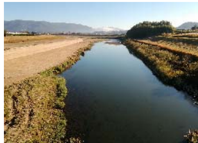
【川内川本川亀沢橋から 上流を望む】
