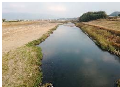
【川内川本川亀沢橋から 上流を望む】
