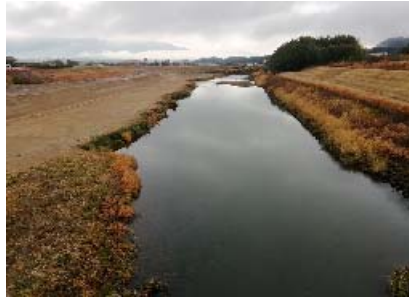
【川内川本川亀沢橋から 上流を望む】
