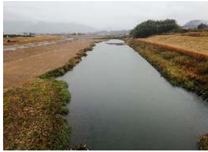
【川内川本川亀沢橋から 上流を望む】
