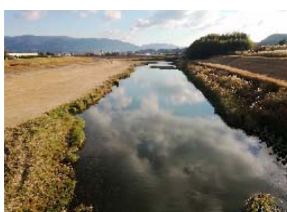
【川内川本川亀沢橋から 上流を望む】
