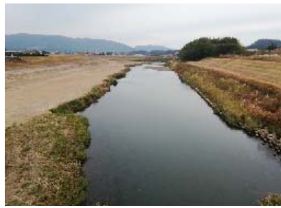
【川内川本川亀沢橋から 上流を望む】
