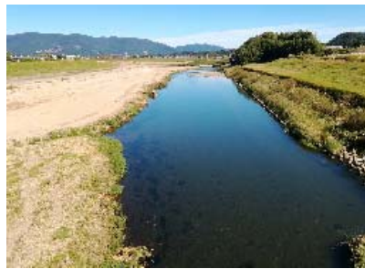
【川内川本川亀沢橋から 上流を望む】
