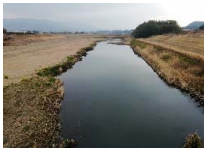
【川内川本川亀沢橋から 上流を望む】
