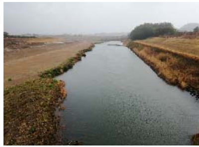
【川内川本川亀沢橋から 上流を望む】
