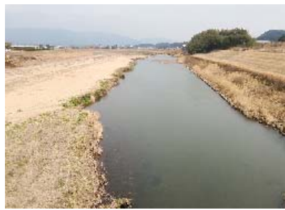
【川内川本川亀沢橋から 上流を望む】
