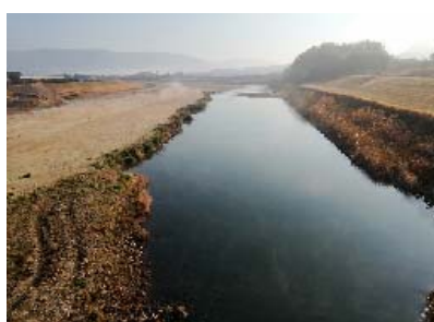
【川内川本川亀沢橋から 上流を望む】
