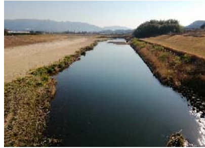
【川内川本川亀沢橋から 上流を望む】
