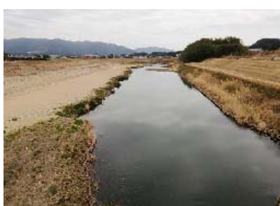
【川内川本川亀沢橋から 上流を望む】
