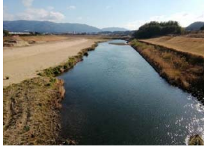
【川内川本川亀沢橋から 上流を望む】
