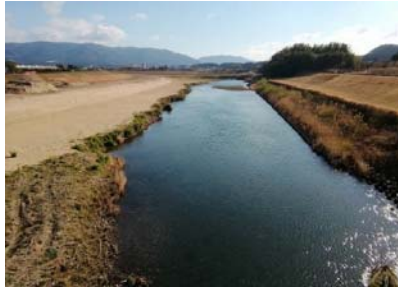
【川内川本川亀沢橋から 上流を望む】
