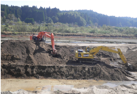
河道掘削の施工状況（羽月川）
