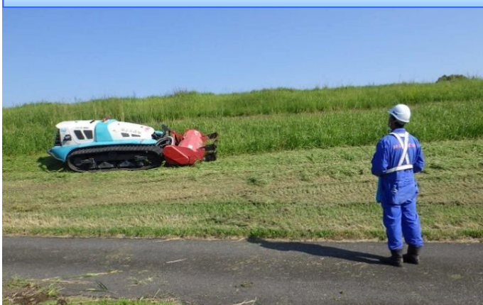
堤防の除草作業の状況
