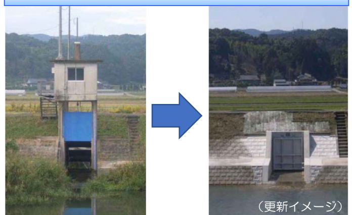
樋門樋管のフラップゲート化
