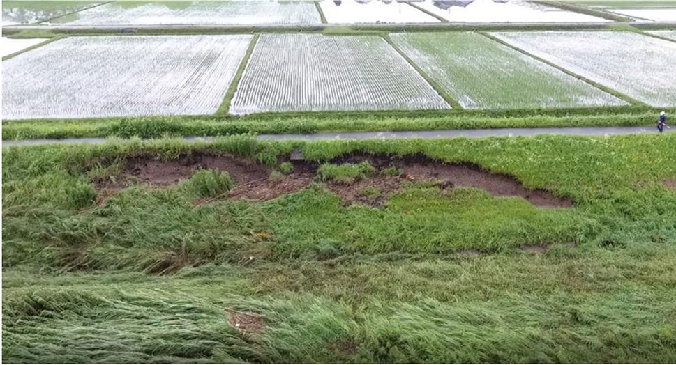
⇨ 令和3年7月10日の出水により、堤防の洗掘が発生
