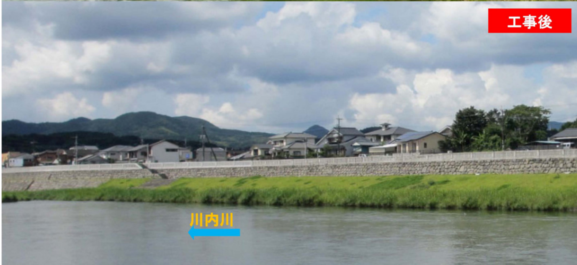
宮之城橋周辺の堤防の護岸改築(さつま町)
