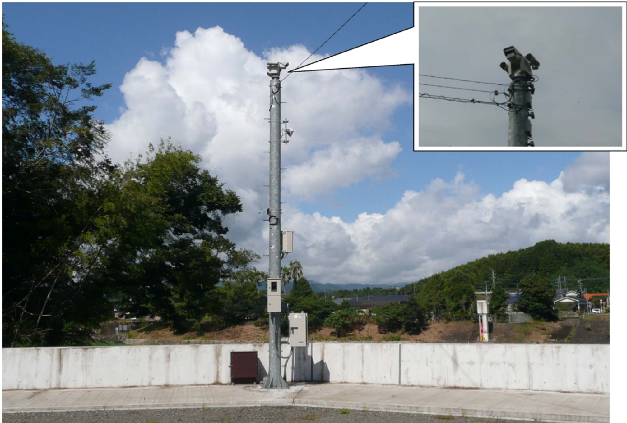
かんし 監視カメラ(宮之城水位流量観測所)
