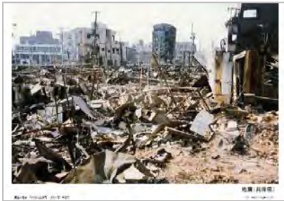
H7阪神・淡路大震災による被害状況
