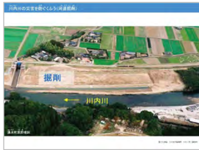
河道掘削 (掘削後の様子)
