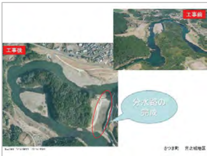
分水路 (工事前後の比較写真)
