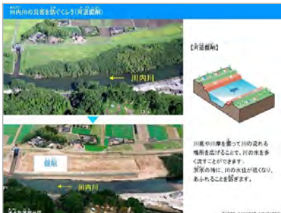
河道掘削 (説明写真)
