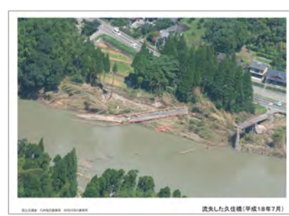
H18.7月大雨 (薩摩川内市久住橋)
