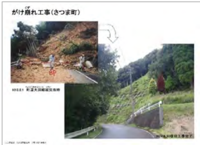
がけ崩れ工事 (さつま町)
