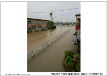
R3.7月豪雨 (薩摩川内市春田川 中ノ原橋付近)
