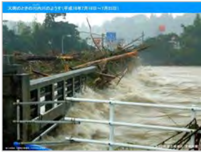
H18.7月豪雨（さつま町宮之城地区（宮都大橋））
