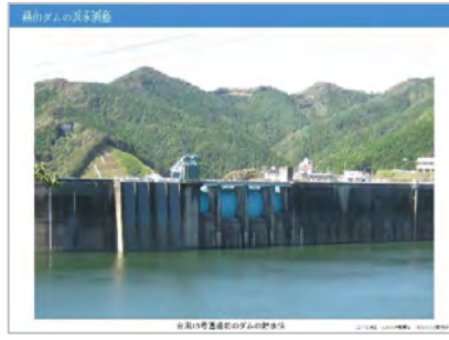
鶴田ダム (洪水調整_台風15号通過前の ダムの貯水位)
