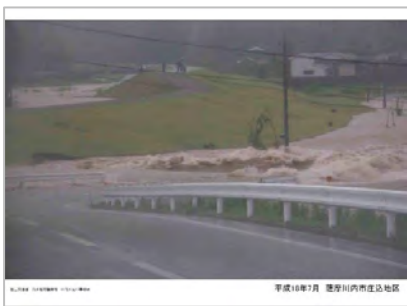
H18.7月豪雨 (薩摩川内市庄込地区)
