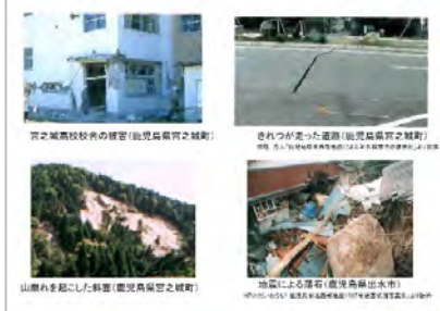
H9鹿児島県北西部地震による被害状況①
