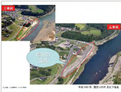
堤防 (工事前後の比較写真) ②
