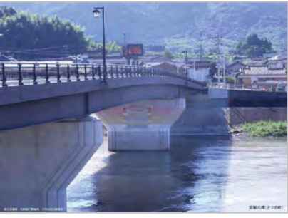
避難等の目安となる水位線 表示 (宮都大橋 (さつま町))
