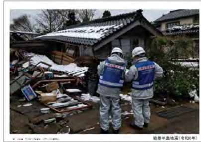
R6能登半島地震による被害状況⑧
