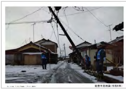
R6能登半島地震による被害状況⑥
