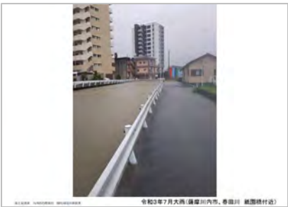
R3.7月豪雨 (薩摩川内市春田川祇園橋付近)
