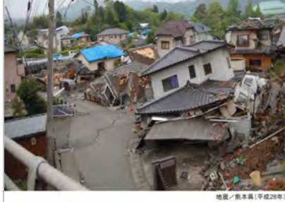
H28熊本地震による被害状況①
