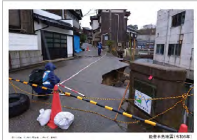
R6能登半島地震による被害状況④
