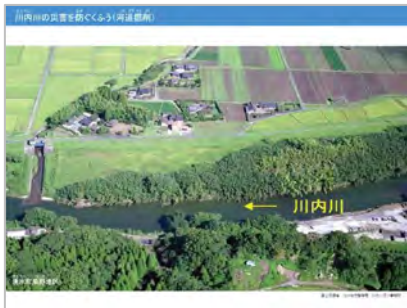
河道掘削 (掘削前の様子)
