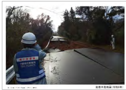
R6能登半島地震による被害状況③
