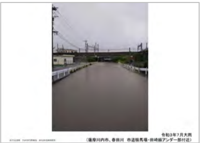
R3.7月豪雨 (薩摩川内市春田川市 道横馬場・田崎線アンダー部分近)
