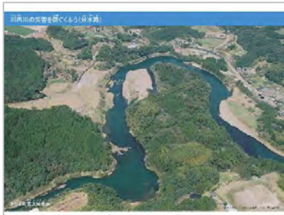
分水路 (航空写真①)
