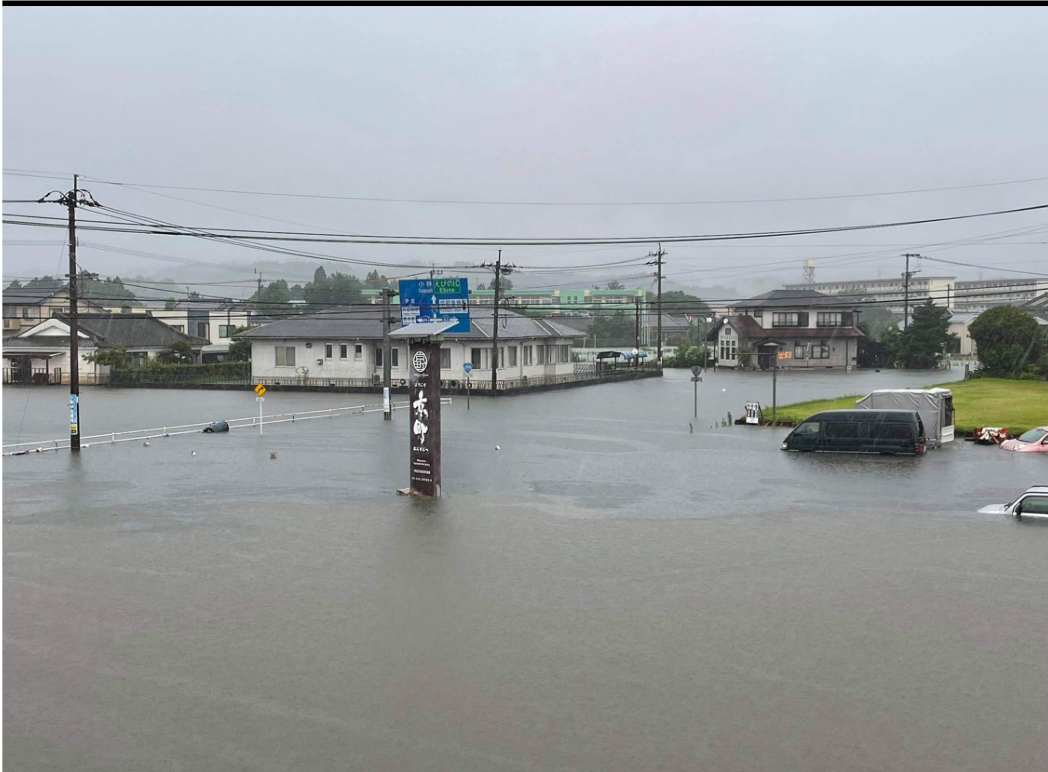
令和3年出水の被害状況(えびの市)
