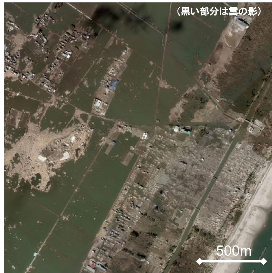
被災後(平成23年3月12日撮影)
