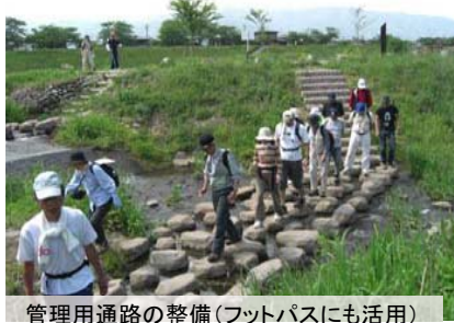
管理用通路の整備(フットパスにも活用)
