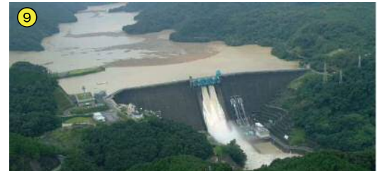
H18.7.23鶴田ダムの状況(ダム下流側)
