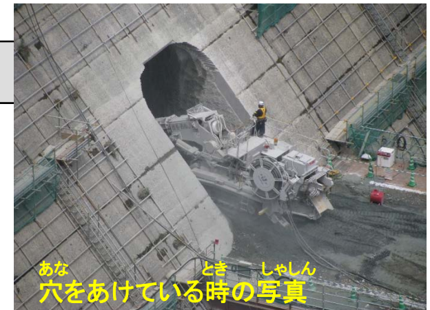
掘削機(穴をあける機械) ＜ブームヘッダー＞
