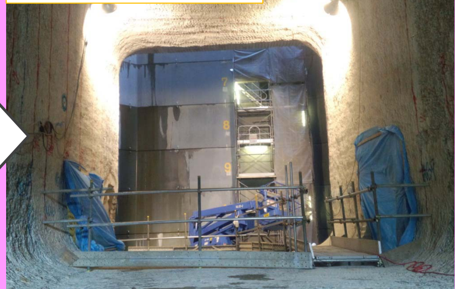
削孔内の様子(発電1号) (撮影:H25.11.22)
