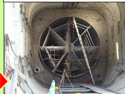
コンクリート充填完了
