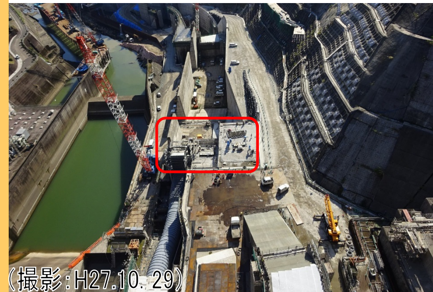
放流ゲート設置箇所
