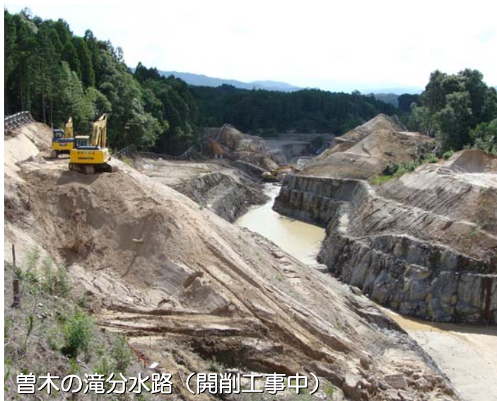
推進分水路(開削工事中)
