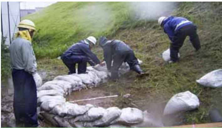
川内川左岸12k600付近〔薩摩川内市天辰地先〕 月の輪工法の実施状況
