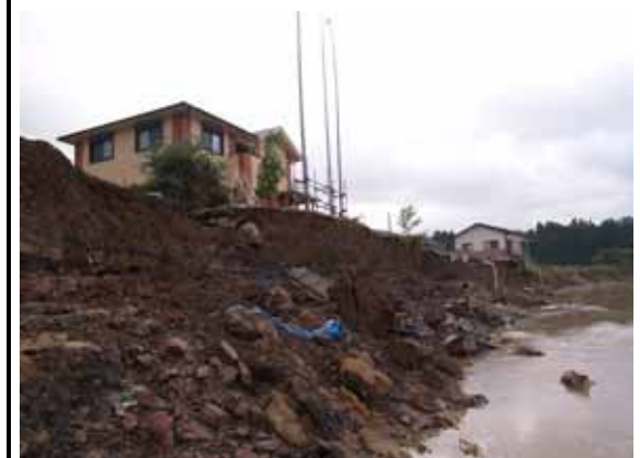
薩摩川内市東郷町五社下地先 川内川右岸19 / 800付近
