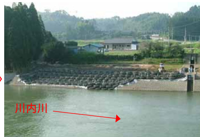
復旧状況 袋詰玉石設置
