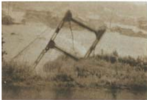
流失した湯田吊橋
