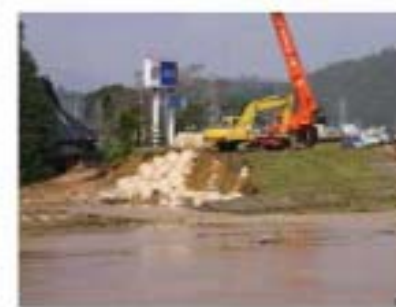
出石川左岸5.4km付近の破堤の状況
