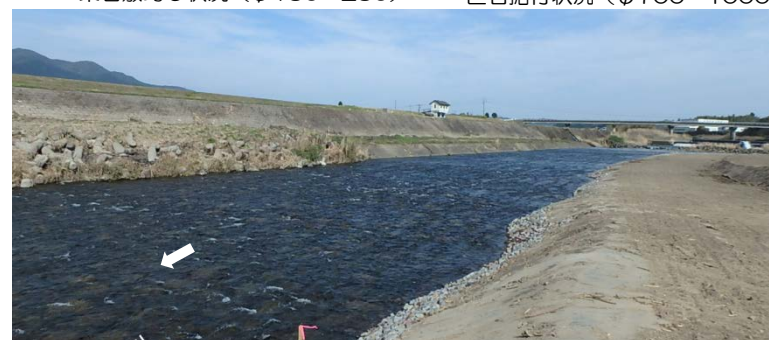
施工完了状況（111k600付近）H28.3月
