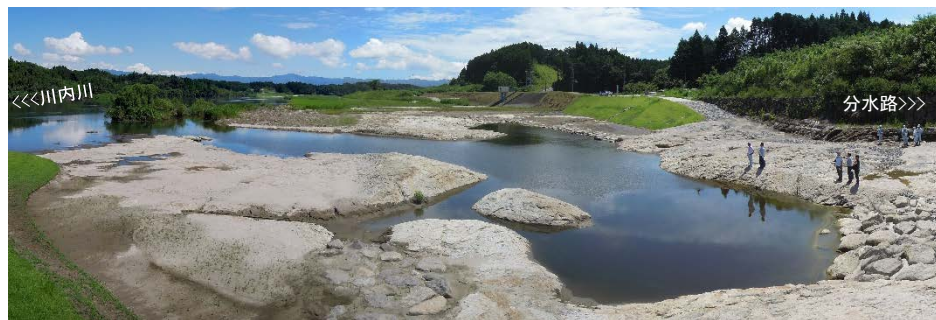
切り下げ完了後の呑口全景
