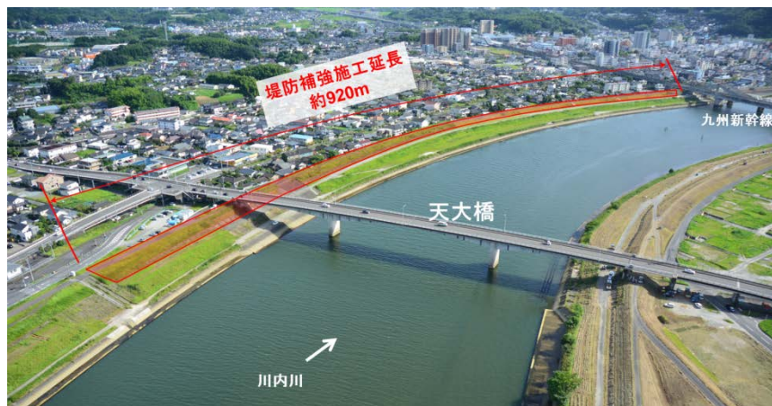
堤防補強実施箇所（白和地区）
