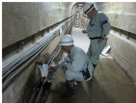
堤体の挙動観察（漏水量測定）の状況
