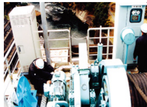
管理施設点検（ゲート巻上機の点検）の状況
