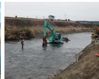
巨石据付状況（φ700～1000）
