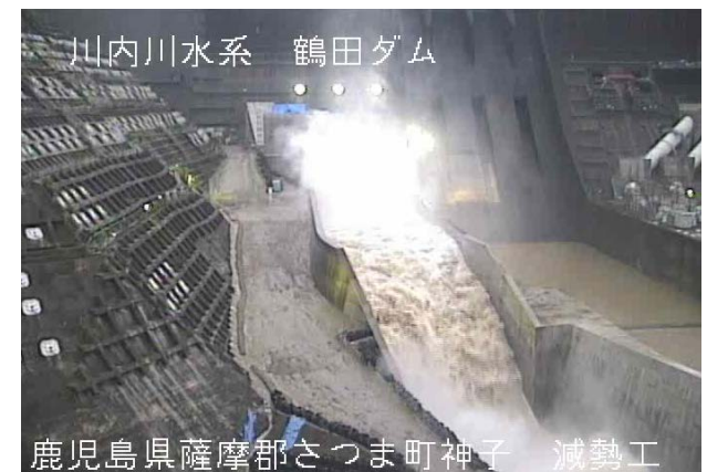
増設ゲートからの放流量 約 840 m^3 /秒
