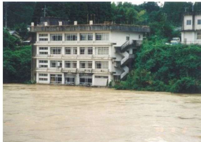
向田地区浸水状況(薩摩川内市)
