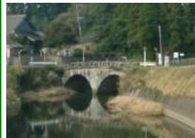
江之口橋(薩摩川内市)
