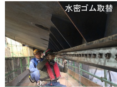
湯之尾堰の開閉装置改修、ローラ改修及び水密ゴム取替の更新等
