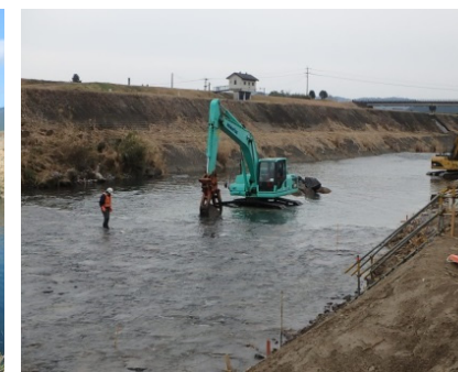
巨石据付状況 (φ700～1000)
