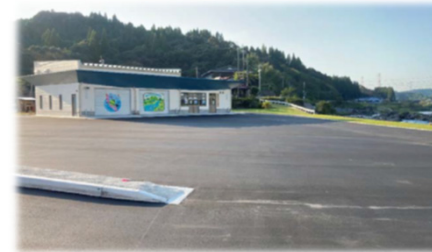
カヌー艇庫（湧水町整備）
