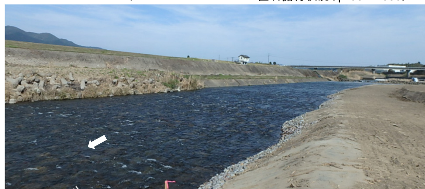
施工完了状況 (111k600付近) H28.3月
