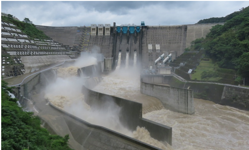
洪水調節中のゲート放流状況 (4日13時30分頃)
