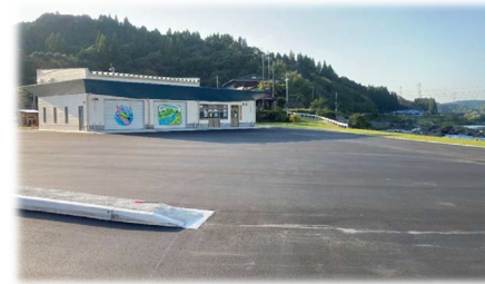
カヌー艇庫（湧水町整備）
