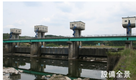
湯之尾堰の開閉装置改修、ローラ改修及び水密ゴム取替の更新等
