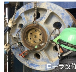
湯之尾堰の開閉装置改修、ローラ改修及び水密ゴム取替の更新等
