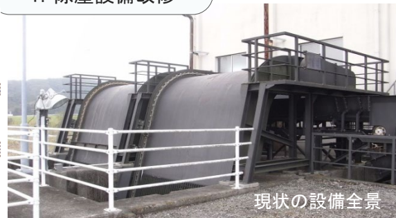
除塵設備本体の耐腐食性能向上（ステンレス化）及び設備構成機器更新等
