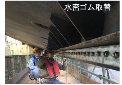
湯之尾堰の開閉装置改修、ローラ改修及び水密ゴム取替の更新等
