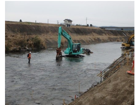
巨石据付状況(φ700~1000)
