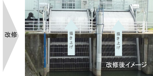
除塵設備本体の耐腐食性能向上（ステンレス化）及び設備構成機器更新等
