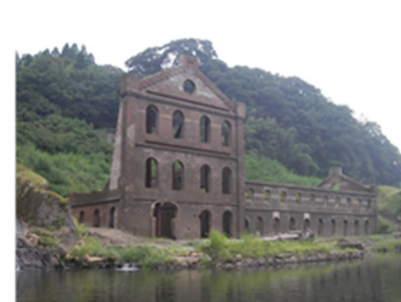
曾木発電所遺構
