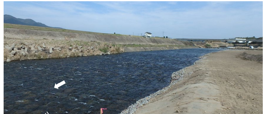
施工完了状況(111k600付近) H28.3月
