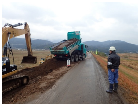
堤防強化工事状況(川内川左岸94k800付近)
