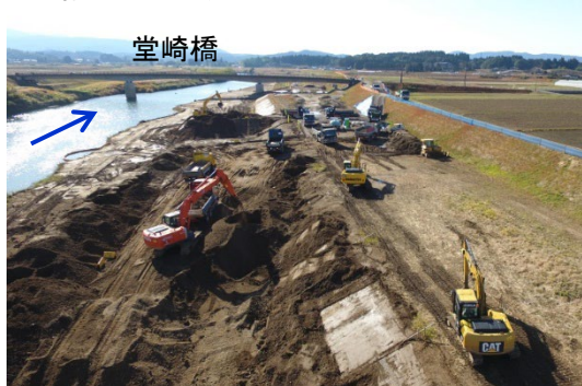
河道掘削状況(羽月川右岸1k300付近)
