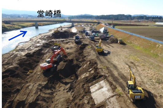
河道掘削状況(羽月川右岸1k300付近)
