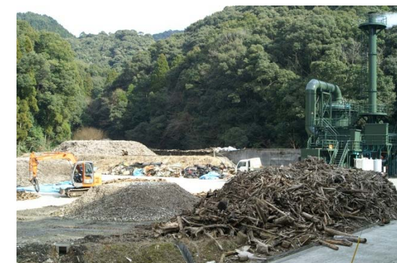
流木塵芥処理の状況
