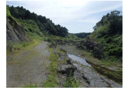
曾木の滝分水路の完成状況
