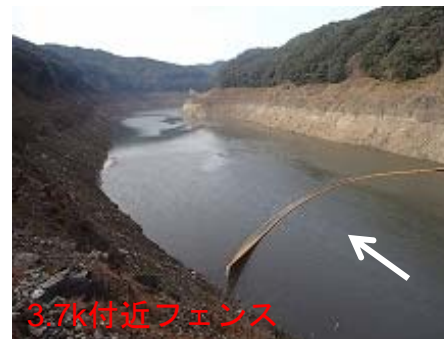
濁水フェンスの設置の設置状況
