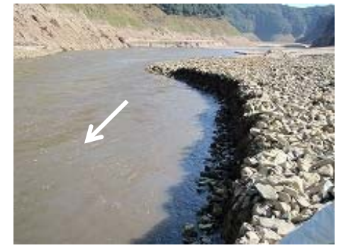
水位低下後の湖内水路の設置状況
