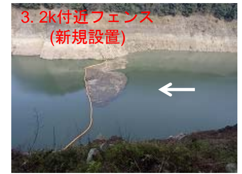
濁水フェンスの設置の設置状況
