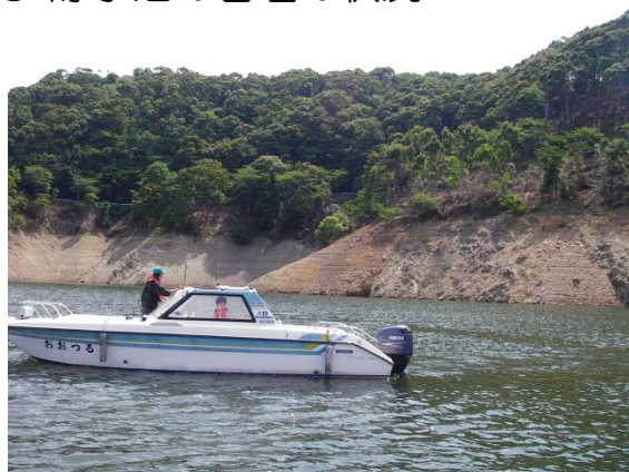
貯水池の巡視の状況
