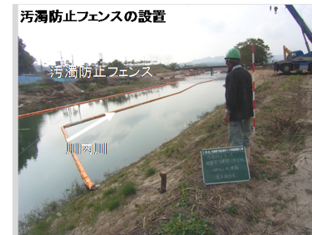
濁水対策の状況
