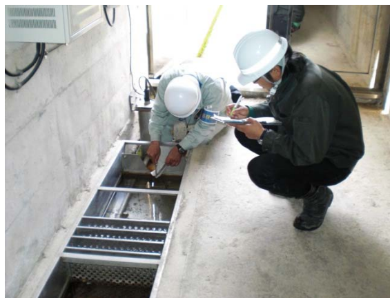
堤体の挙動観察（漏水量測定）の状況
