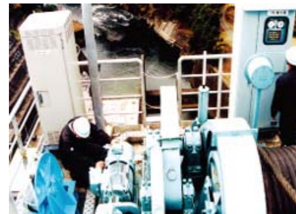
管理施設点検（ゲートの点検）の状況
