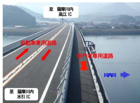
川内川大橋（小倉地区から高江地区方向を望む）
