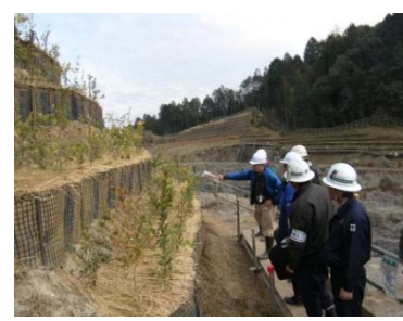
専門家による現地指導状況
