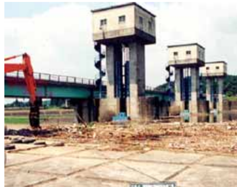
写真 4.3.16 湯之尾堰上流に堆積した塵芥の除去状況
