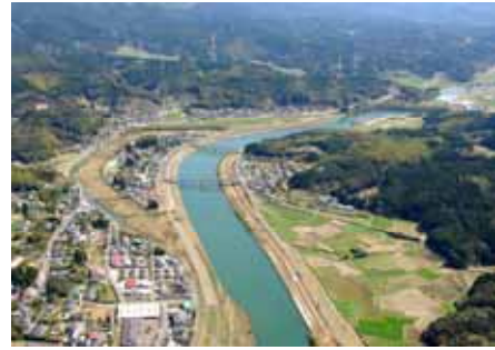
写真 1.2.18 湯之尾捷水路
