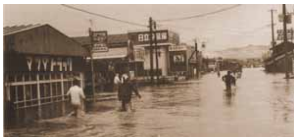
写真 1. 2. 6(1) 上川内地区浸水状況（薩摩川内市）
