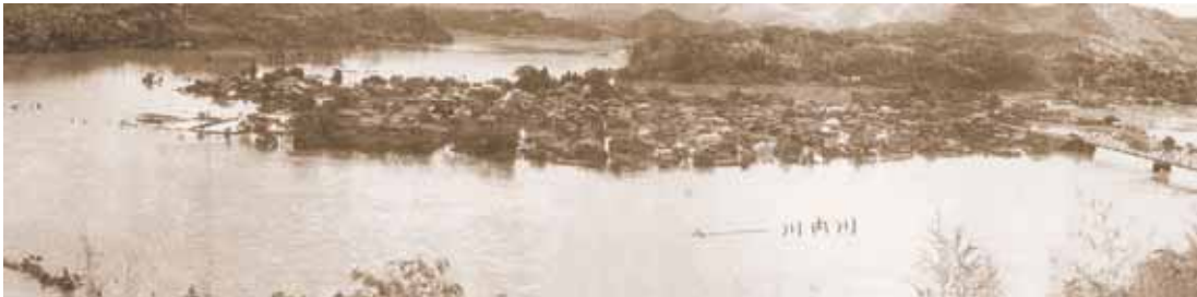
写真 1.2.1 東郷地区浸水状況（薩摩川内市）
