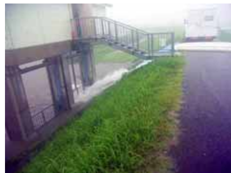
写真 4.3.5 排水ポンプ車の稼動状況 (平成 18 年 7 月 23 日洪水時)
