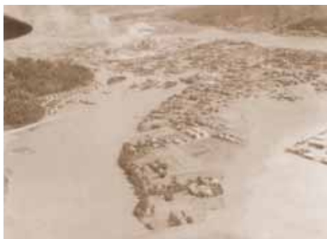
写真 1. 2. 5(1) 支川高城川の氾濫状況（薩摩川内市）
