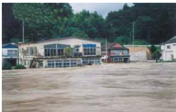
写真 1. 2. 11 (4) 湯之尾地区浸水状況 (伊佐市)
