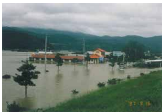
写真 1. 2. 11 (2) なかがわ 中津川地区浸水状況 (湧水町)
