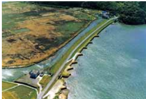
写真 2. 2. 38 長崎堤防 (薩摩川内市) 長崎堤防は、川内川 4km 付近左岸に位置する鋸歯状の堤防である。堤長 360 間 (648m) で、7つの鋸歯状に石垣が築かれている。
