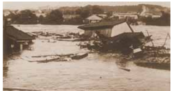
写真 1. 2. 7(2) 家屋流出状況 (さつま町)
