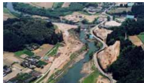
写真 1.2.20 轟狭窄部の開削工事（湧水町）
