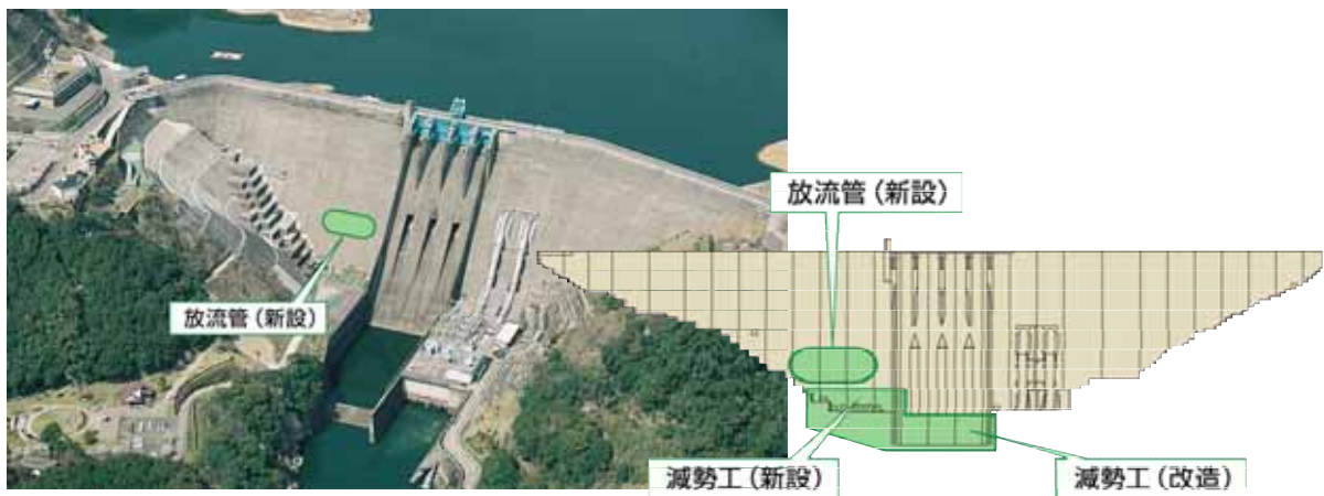
図 4.2.5 鶴田ダム施設改造イメージ
