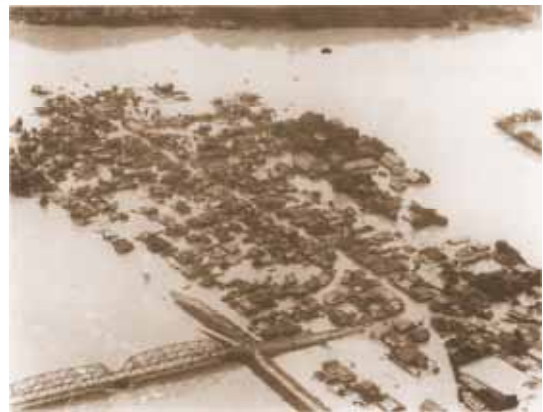
写真 1.2.2 東郷地区浸水状況 （薩摩川内市）
