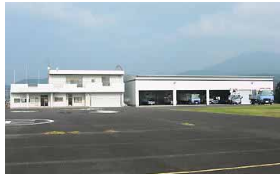
写真 4.2.2 防災ステーション（湧水町）
