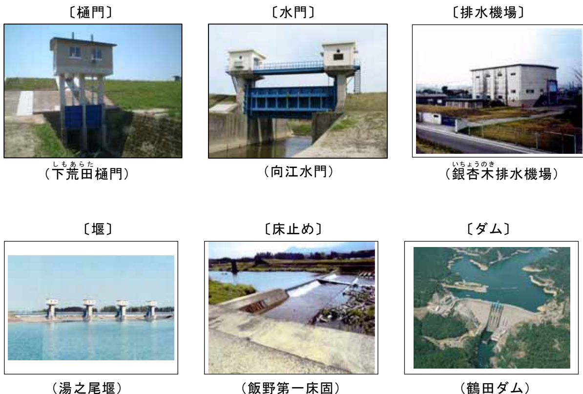
写真 2.1.2 河川管理施設
