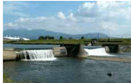
写真 1.3.1 現在の堂本堰
