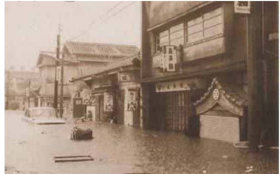
写真 1. 2. 3(2) 市街地浸水状況 (薩摩川内市)
