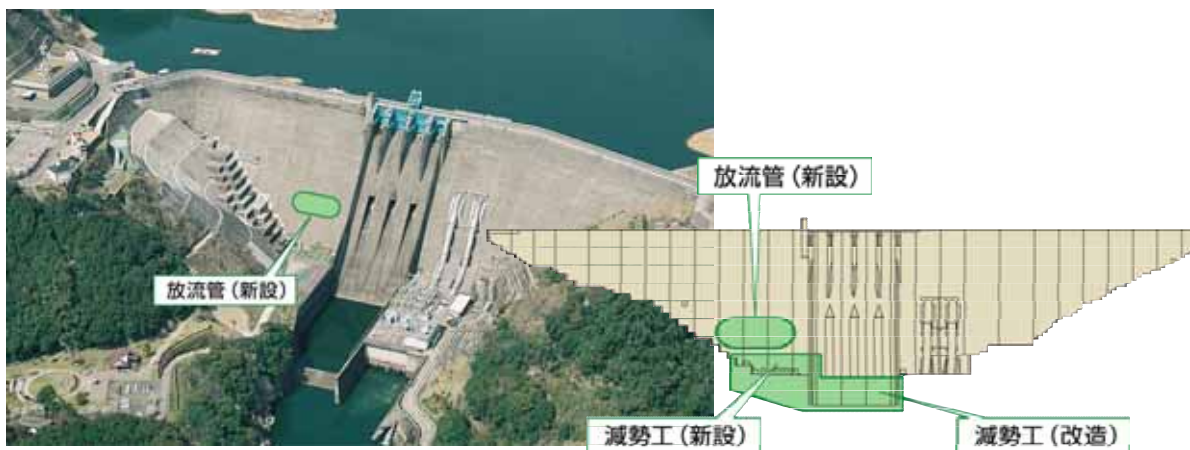
図 4. 2. 11 (2) 鶴田ダムブロックイメージ図
