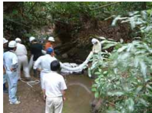
写真 2.2.14 オイルフェンス設置状況
