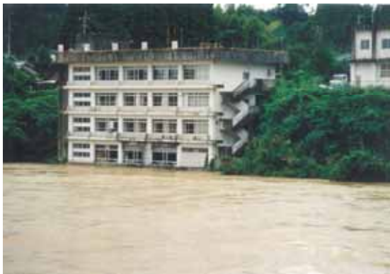
写真 1.2.10(1) かわぐち 川口地区浸水状況(さつま町)
