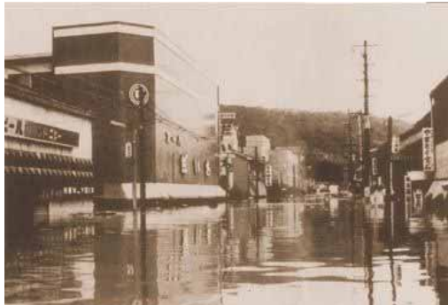
写真 1. 2. 3(1) 市街地浸水状況 (薩摩川内市)
