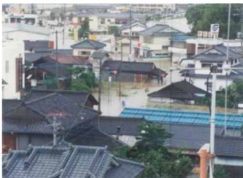
写真 1. 2. 8(1) 栗野地区浸水状況 (湧水町)
