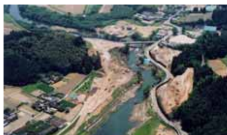
写真 1.2.20 轟狭窄部の開削工事（湧水町）
