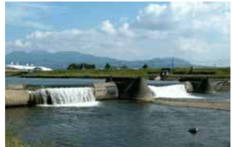
写真 1.3.1 現在の堂本堰
