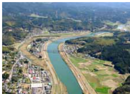
写真 1.2.18 湯之尾捷水路
