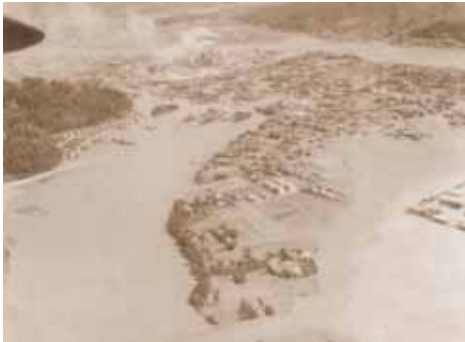
写真 1. 2. 5(1) 支川高城川の氾濫状況（薩摩川内市）
