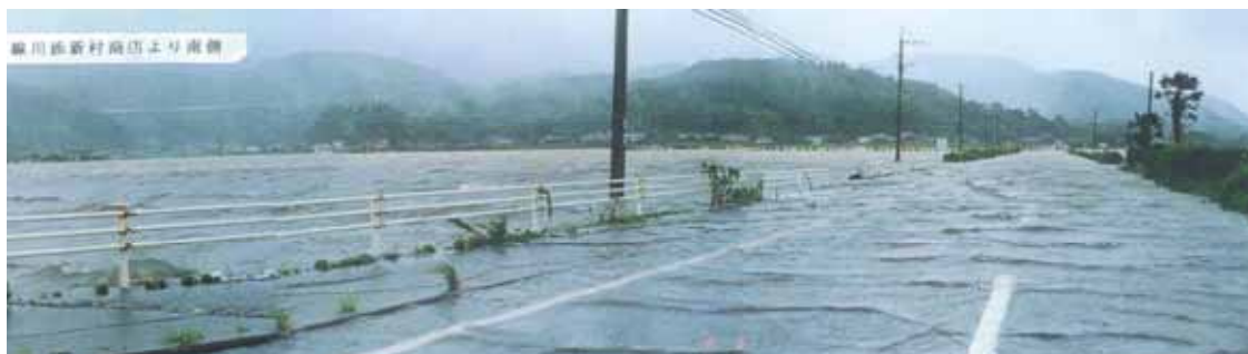
写真 1.2.9 かわそえ 川添地区浸水状況(湧水町)
