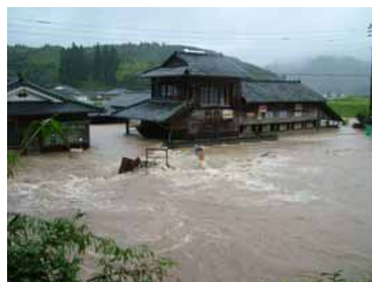
写真 1.2.13(2) 川添地区浸水状況 (湧水町)
