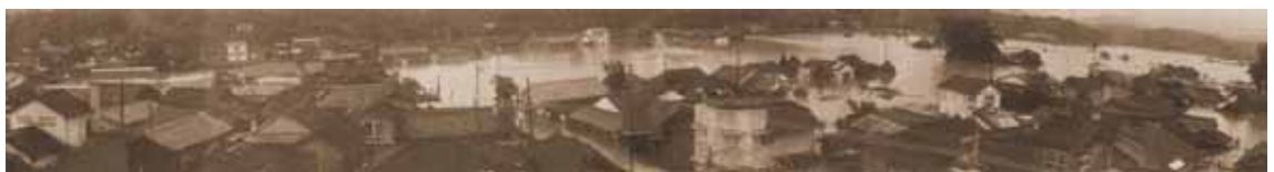
写真 1. 2. 4 栗野地区浸水状況（湧水町）
