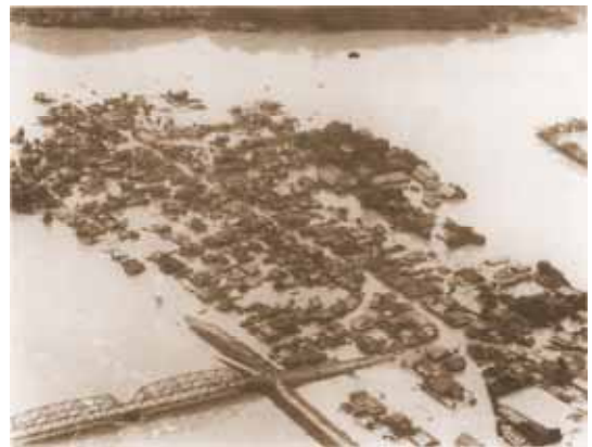
写真 1.2.2 東郷地区浸水状況 （薩摩川内市）
