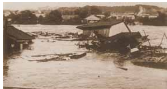
写真 1.2.7(2) 家屋流出状況 (さつま町)
