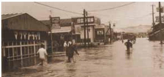
写真 1. 2. 6(1) 上川内地区浸水状況（薩摩川内市）
