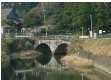
写真 2. 2. 39 江之口橋 (薩摩川内市) 薩摩川内市高江町峰山小学校の横の八間川に架る嘉永2年 (1849年) に肥後の石工・岩永三五郎によって、架設された眼鏡橋。
