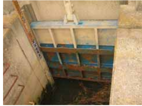
【小倉排水機場樋門】
