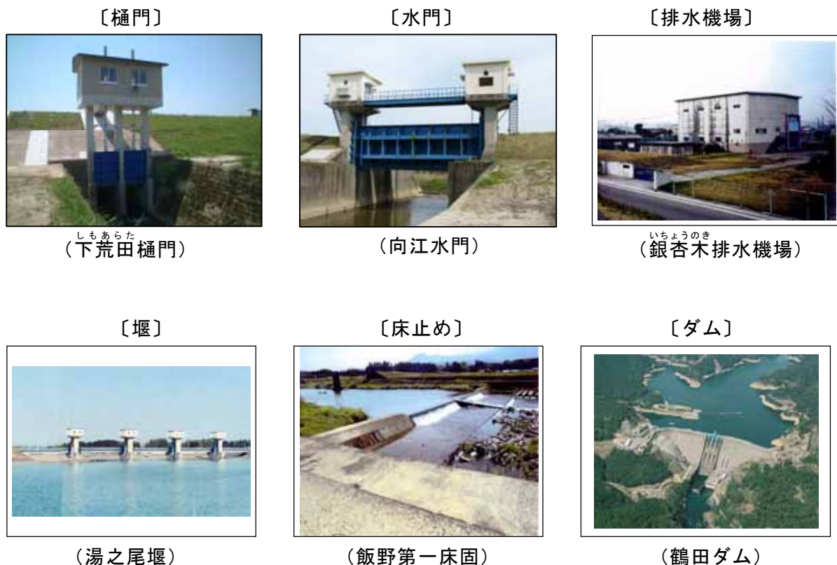
写真 2.1.2 河川管理施設
