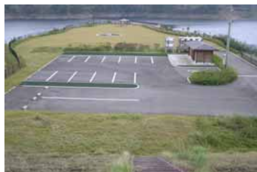
写真 2. 2. 24 大鶴湖打込地区環境整備 (さつま町)
