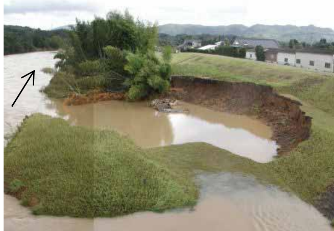
H18.7 洪水 さつま町 かしわぼる 柏原地区（法崩れ）
