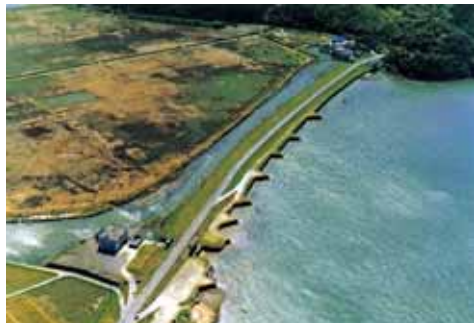
写真 2. 2. 38 長崎堤防 (薩摩川内市) 長崎堤防は、川内川 4km 付近左岸に位置する鋸歯状の堤防である。堤長 360 間 (648m) で、7つの鋸歯状に石垣が築かれている。
