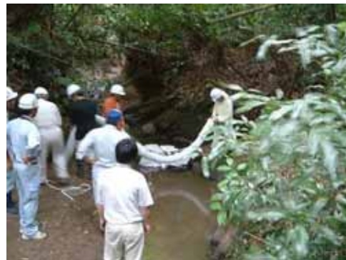
写真 2.2.14 オイルフェンス設置状況
