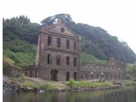
写真 2. 2. 34 曾木発電所遺構
