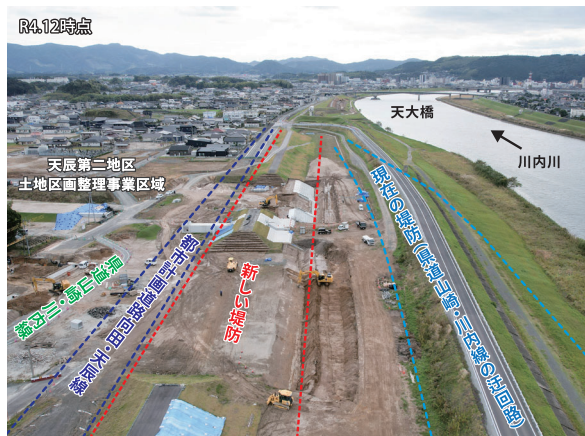
天辰第二地区（工事中）
