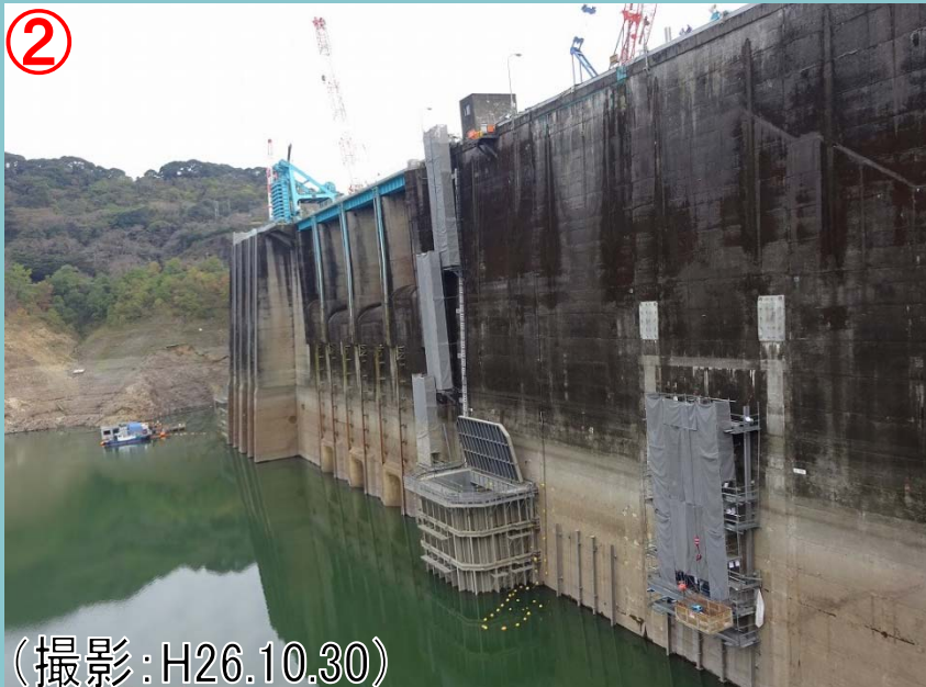
上流仮締切の中の抜水の様子(天端より撮影)
