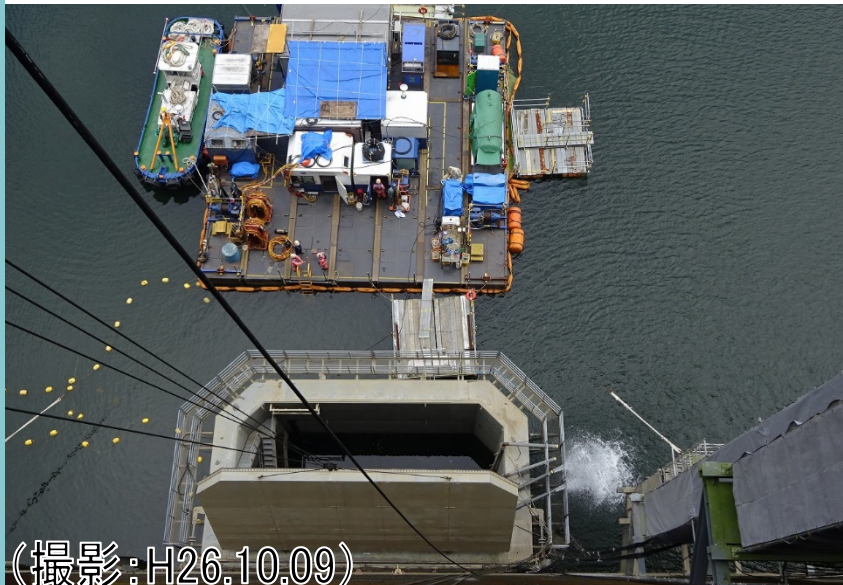
上流仮締切の中の抜水の様子(天端より撮影)
