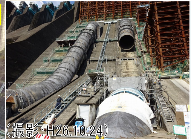
既設発電管撤去後の様子
