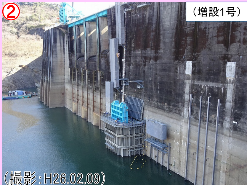
仮締切の上から見た様子(設置状況)
